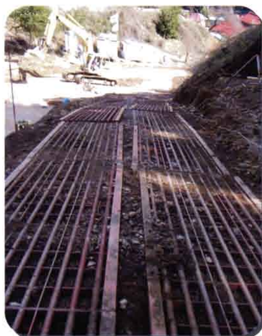
栃木県 砂防ダム工事 ②
