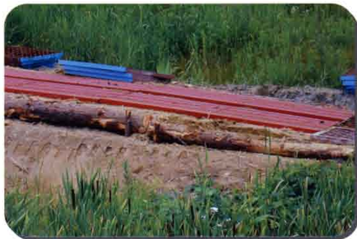
石川県 金沢東部環状道路工事 ②
