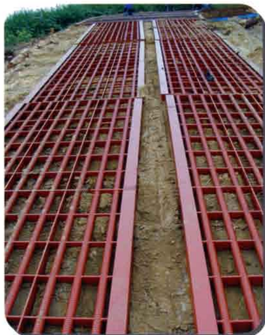
石川県 金沢東部環状道路工事 ①
