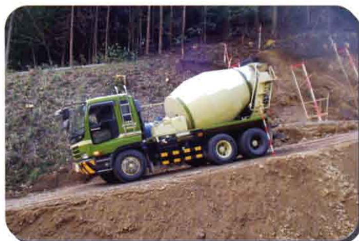
栃木県 砂防ダム工事 ①
