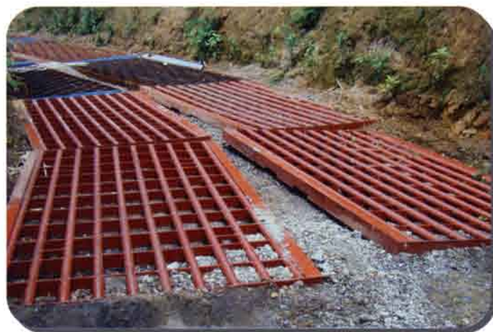
石川県 砂防ダム工事 ②
