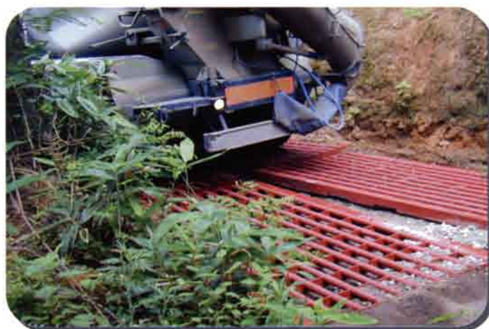
石川県 砂防ダム工事 ①
