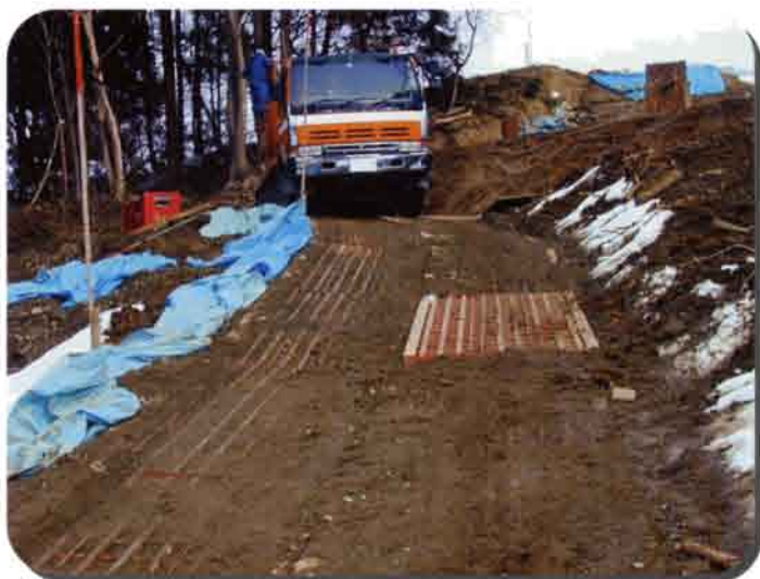
長野県 地滑り対策工事 ②
