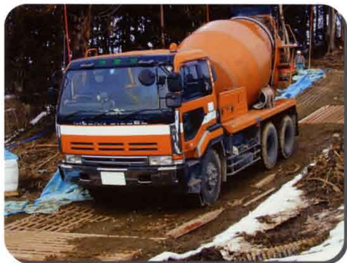
長野県 地滑り対策工事 ①
