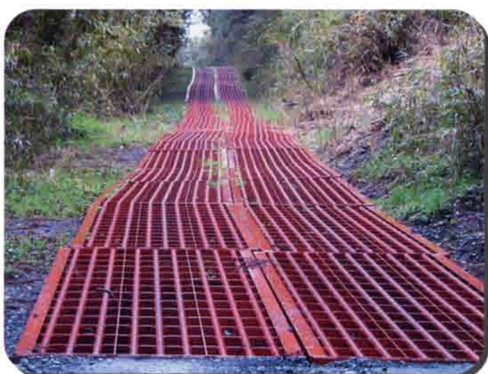
熊本県 送水管設置工事
