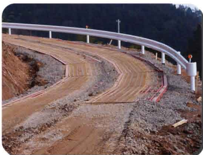
兵庫県 道路建設工事 ②
