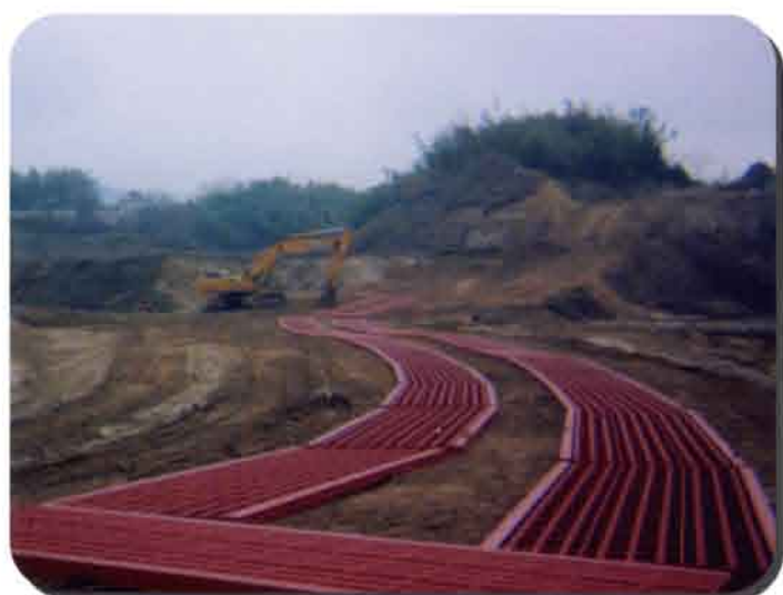
香川県 用水調整池建設工事
