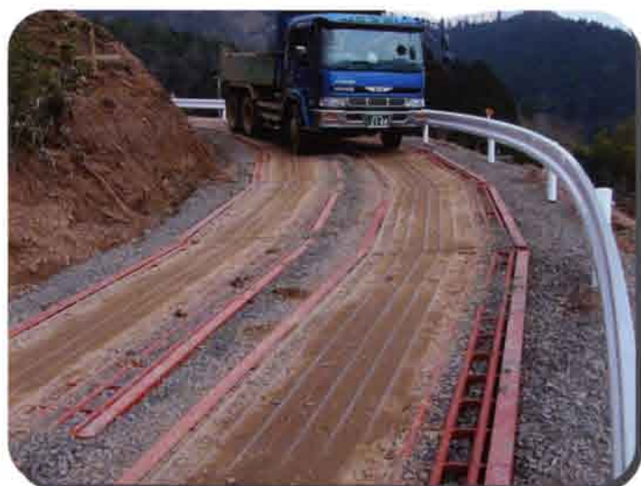
兵庫県 道路建設工事 ①
